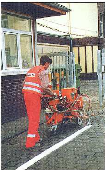
Fahrbahnmarkierungen mit Farbe, retroreflektierender Folie oder mit PREMARK-Dauermarkierung.
