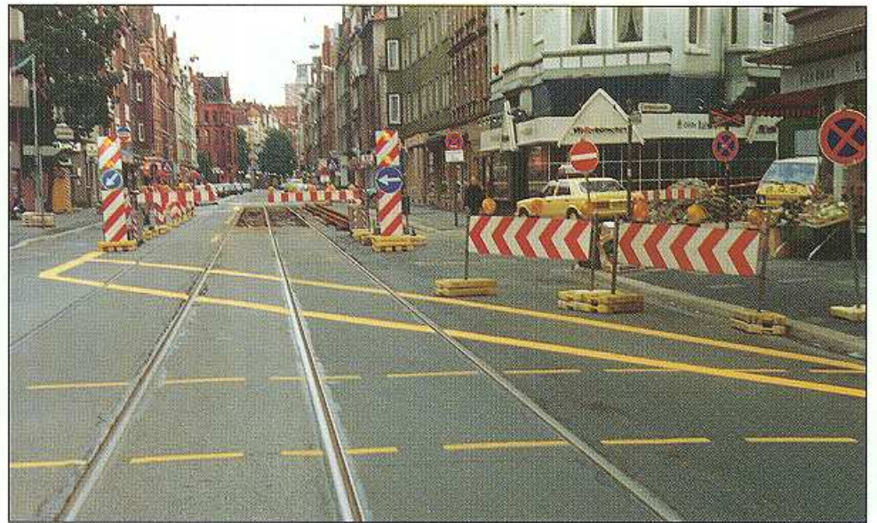
Verschwenkung des Kfz-Verkehrs auf die Gegenfahrbahn mit Richtungswechselverkehr.
