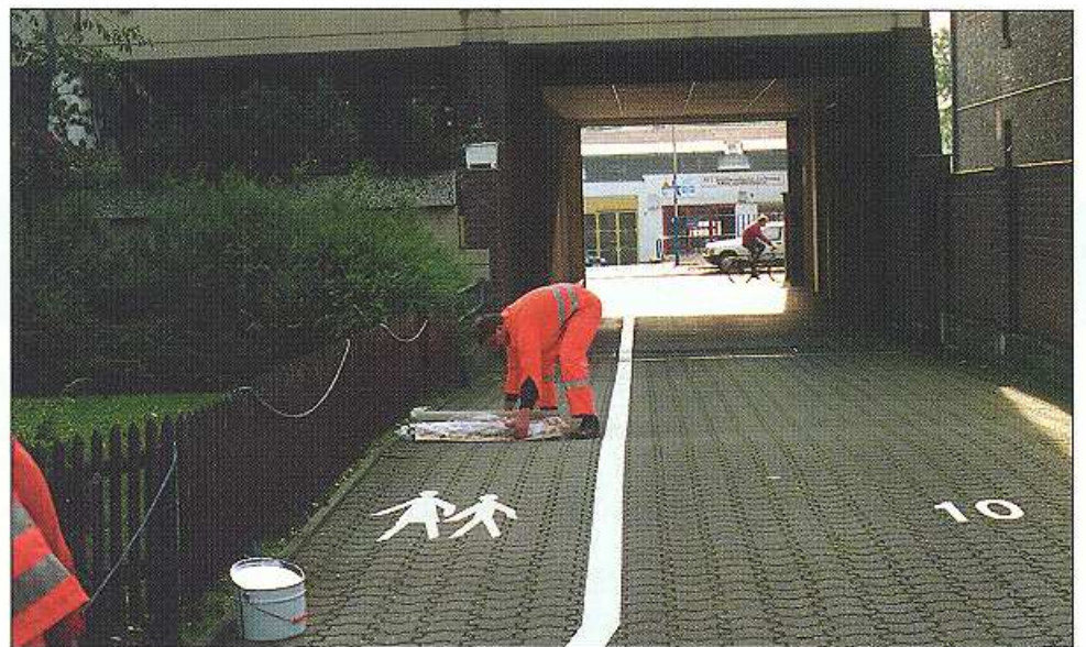
Fahrbahnmarkierungen mit Farbe, retroreflektierender Folie oder mit PREMARK-Dauermarkierung.
